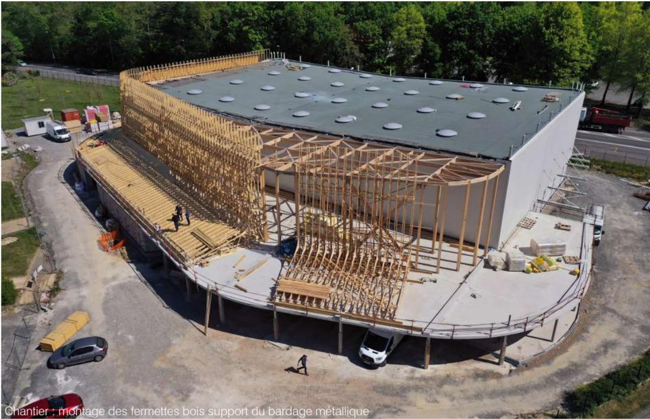
Chantier : montage des fermettes bois support du bardage métallique
